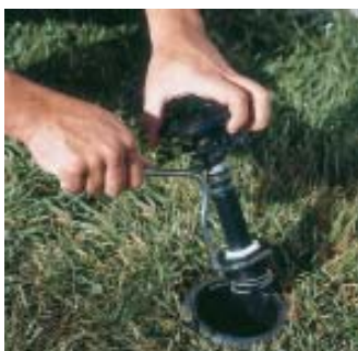
1. Déposer l'intérieur de l'arroseur actuel .
