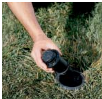
2. Visser l'ensemble porte-buse ATR dans le corps.
